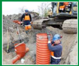
ENTREPRENØR / KLOAK ARBEJDE
